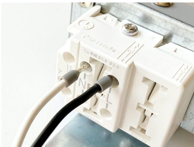
ここはケーブルの先端を穴に真っ直ぐ押し込むと入っていき、留まります。外すときにはマイナスドライバーでNとLの2つの穴の真ん中にあたるT字状の凹み部分を押しとケーブルの先端が抜けてきます。
